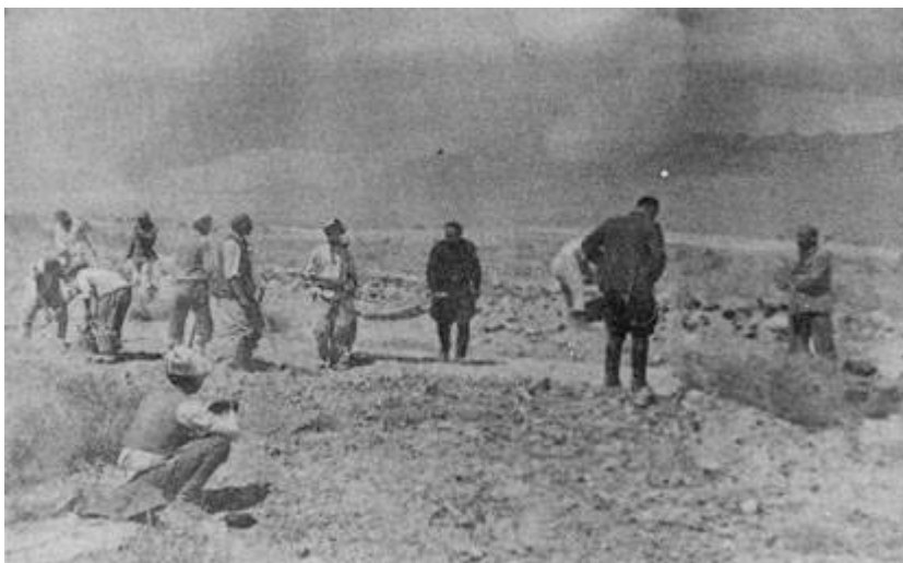
سۇ ئىنشائاتى قۇرۇلۇپ سۇ قۇيۇپ بېرىش
