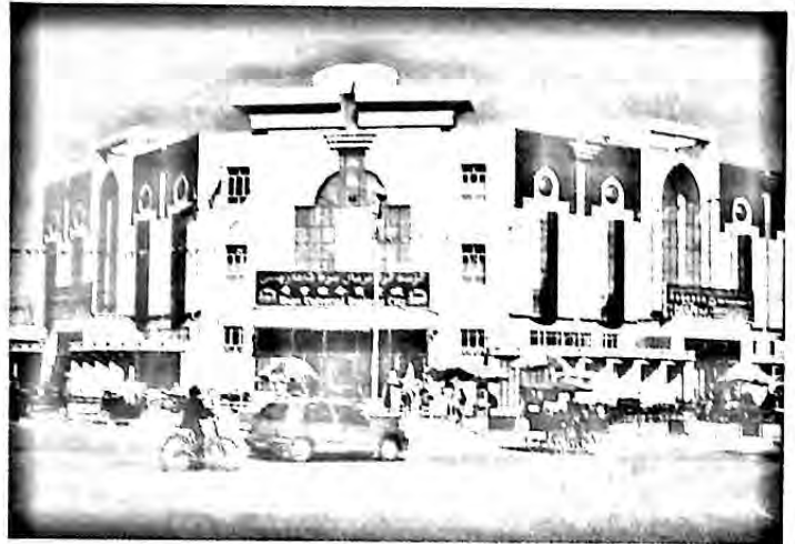
2003 - يىلىنىڭ ئاخىرى يەككە تىجارەتچىلەر بىرلىشىپ مەبلەغ سېلىپ قۇرغان قاراقاش ناھىيىلىك «ئۈمىد» ئۈنۈپىرىمال سودا شەھەرچىسى (قايتا ئىشقا ئورۇنلاشتۇرۇش مۇلازىمەت بىناسى) پۈتۈپ ئىشلىتىلىشكە باشلىدى. دالدا ۋاخىدى فوتوسى
