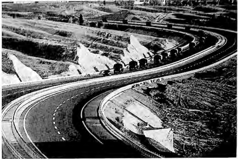
2001 - يىل 4 - ئاينىڭ 28 - كۈنى تۇرپان ئۈرۈمچى - داخۇاڭشەن يۇقىرى سۈرئەتلىك تاشيولى پۈتۈپ تەكشۈرۈپ ئۆتكۈزۈۋېلىشتىن ئۈنۈپ، ئەلا قۇرۇلۇش بولۇپ باھالاندى.
